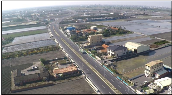
圖 3：縣道 152 線第二標（東陽路） 拓寬工程完工照片
