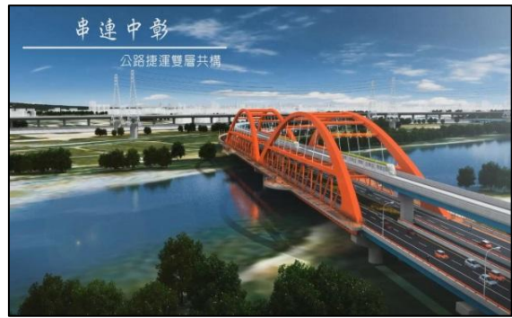
圖 5：金馬東路大肚溪橋公路軌道橋
