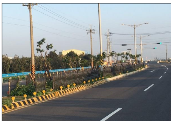
圖 3：152 線 3K+421~11K+500 段道路拓寬及植栽工程完工照片
