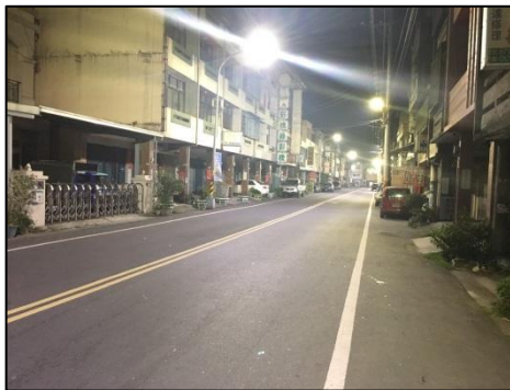
圖 20：二水鄉員集路四段完工照片
