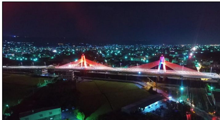
圖 6：高速鐵路彰化站區聯外道路系統改善計畫 高鐵路星光大橋完工夜間照片
