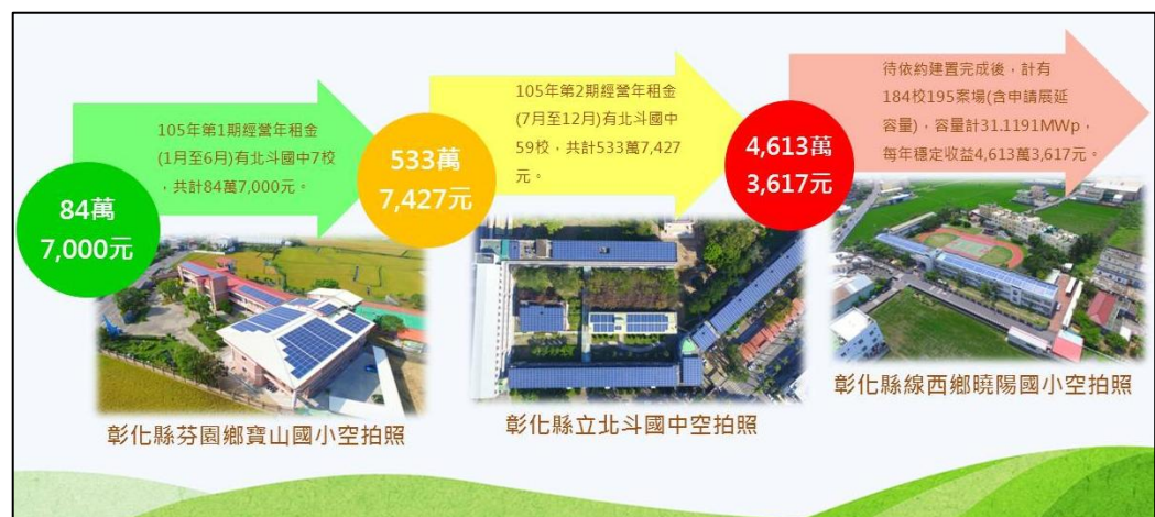
圖 15：學校屋頂設置太陽光電發電系統（經營年租金）
