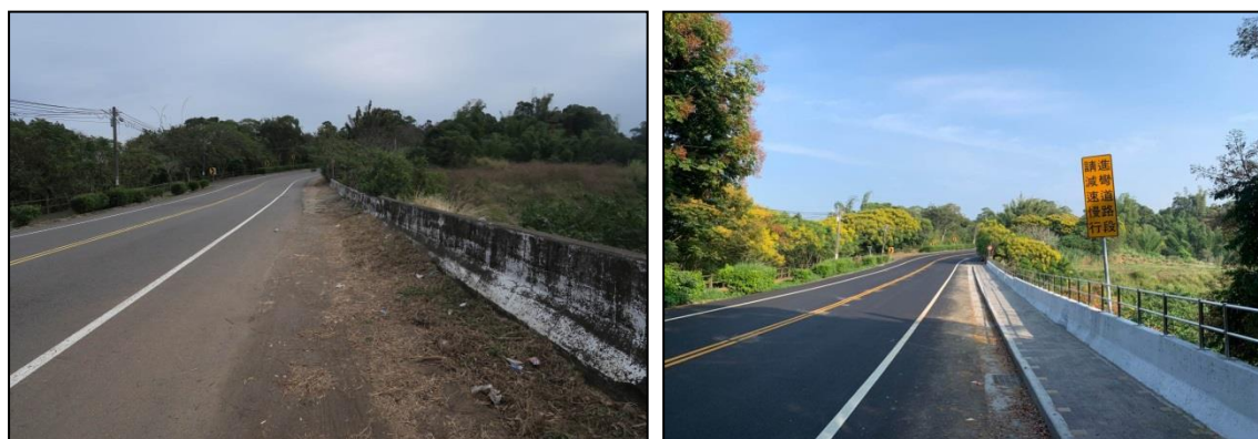
圖 2：縣道 139 線大彰路施工前、後照片
