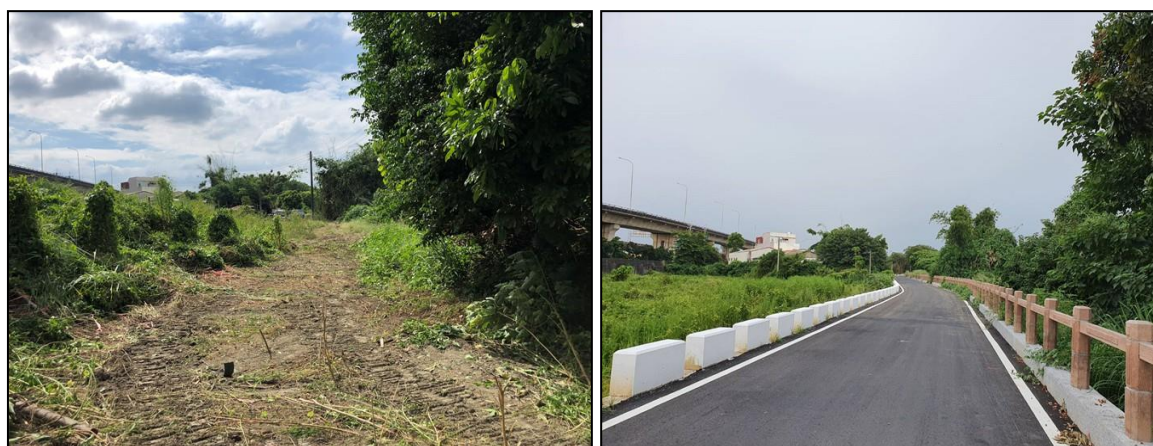
圖 19：東溝排水(第一期)改善工程施工前、後照片
