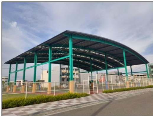
圖 42：田中鎮風雨球場興建工程
