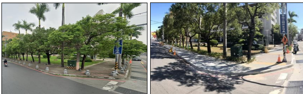
圖 1：彰化市人本城區環境整合計畫施工前、後照片(彰化縣政府前)
