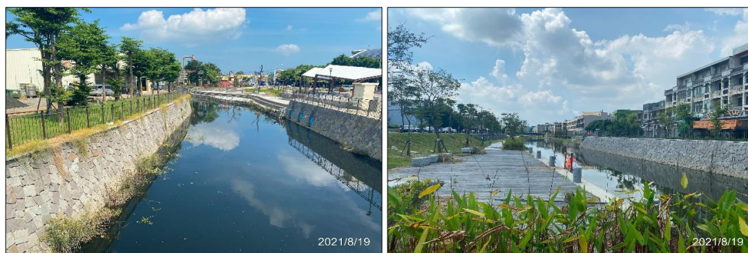
圖 13：鹿港溪排水護岸及水岸環境營造現場
