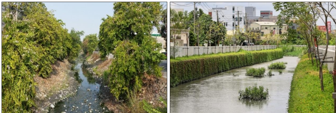
圖 11：石筍排水（第五期）改善整治（前）（後）
