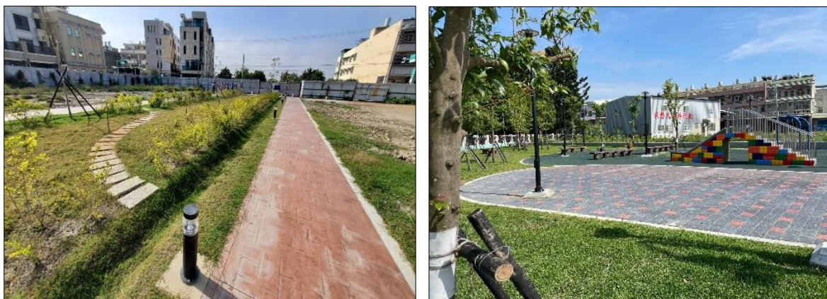
圖6：和美鎮和泰自辦重劃區及埤頭鄉合興南自辦重劃完成現況
