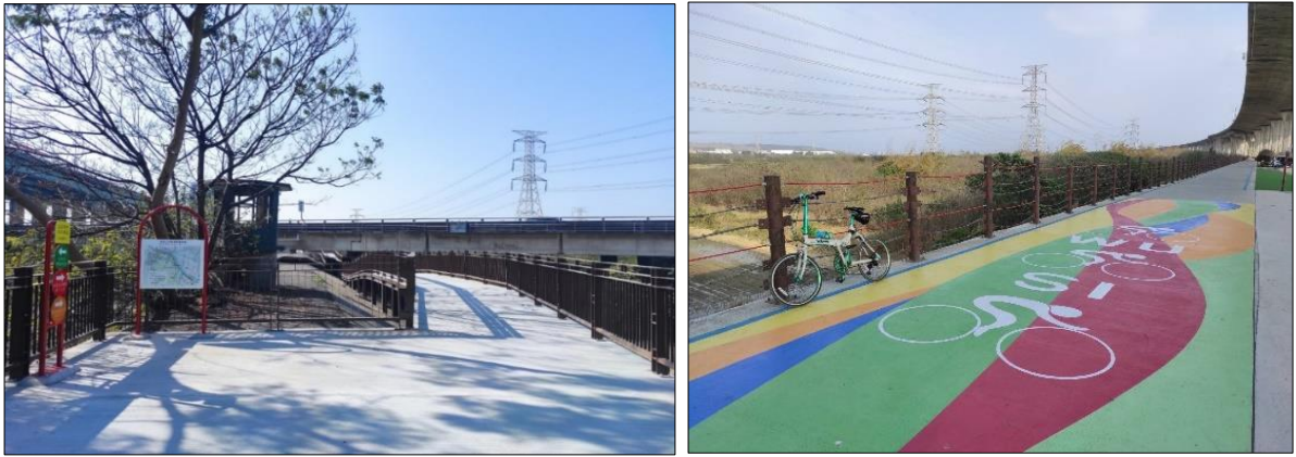
圖 12：烏溪堤防水岸遊憩廊道建置計畫第三期工程
