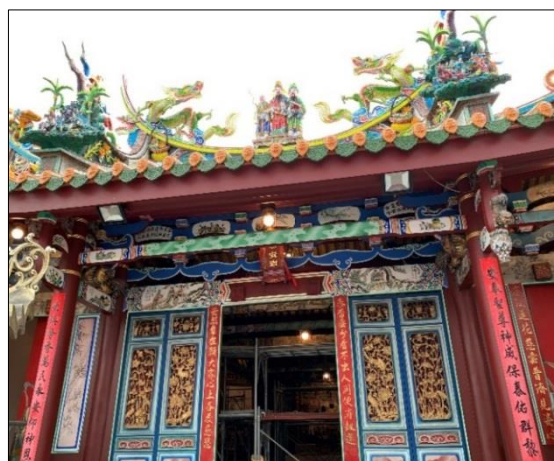
圖 25：泰安岩彩繪施作工程
