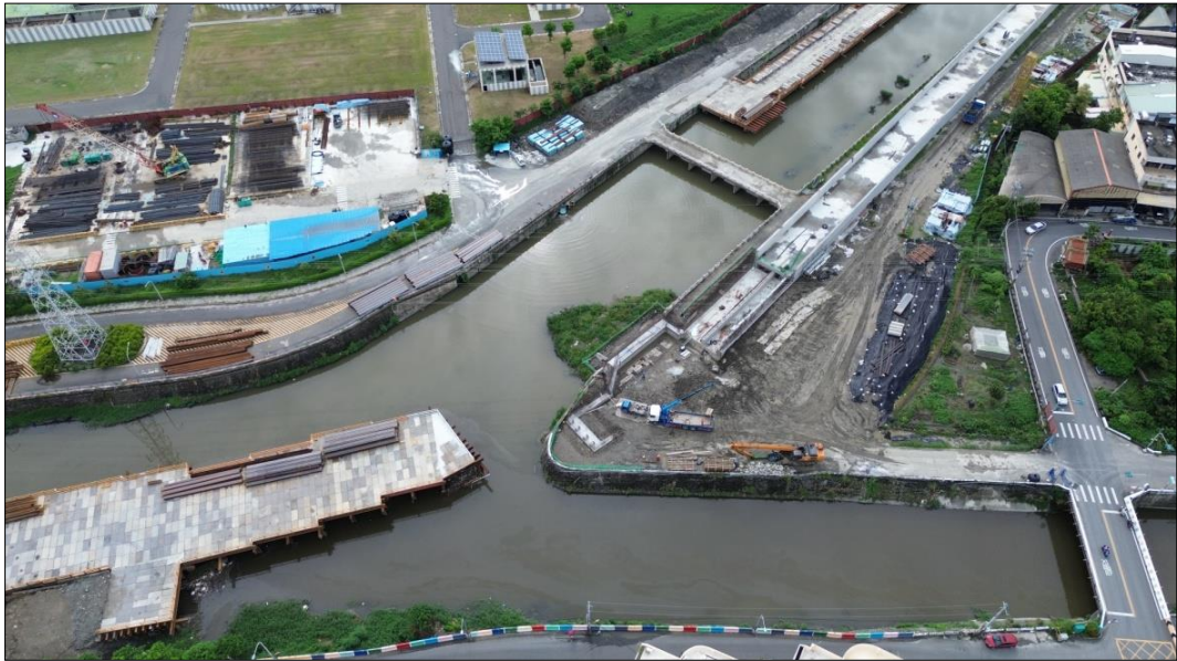
圖 4：大埔截水溝堤岸道路拓寬工程第一工區施工情形
