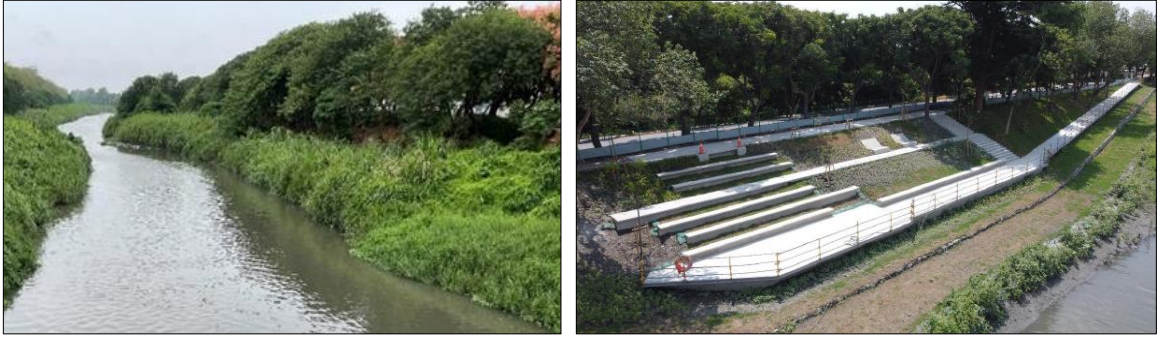
圖 30：東螺溪水綠廊道工程施工前及目前施工照
