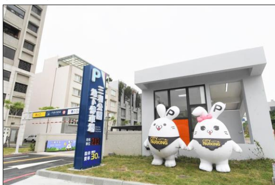
圖 8：員林市三和公園地下停車場完工照
