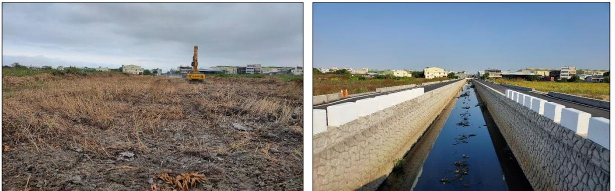
圖8：花壇排水（第二期）上游改道施工前、後照片
