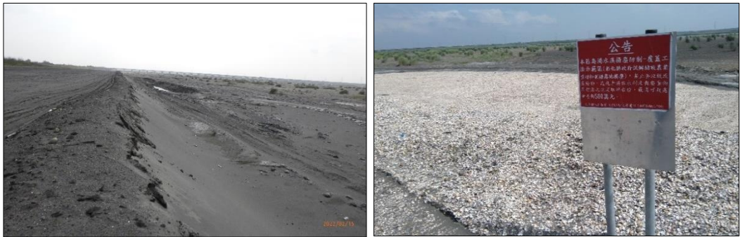
圖 15：濁水溪抑制揚塵文蛤殼鋪設前後照片
