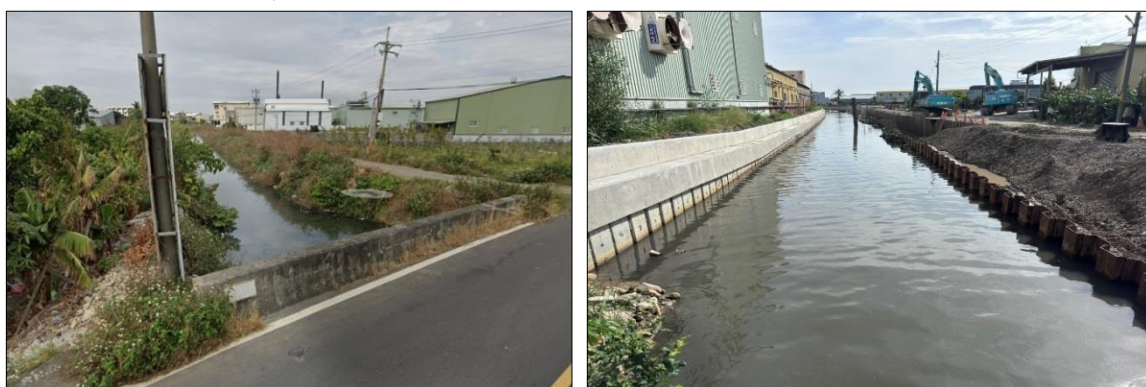
圖 39：番雅溝排水(第五期)改善工程施工前及現場施工中照片
