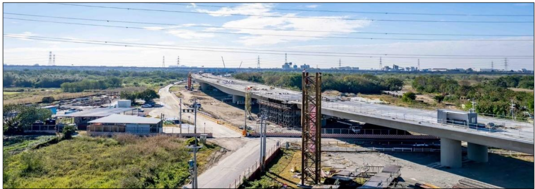
圖 6：臺中大肚—彰化和美跨河橋梁工程施作情形
