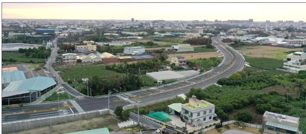
圖 1：東彰道路北段新闢工程第三標完工照
