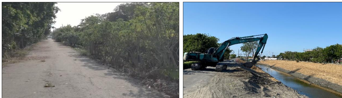
圖 38：二林溪排水周邊景觀改善工程施工前及現場施工中照片
