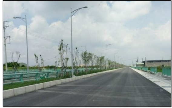
圖 5：高鐵聯外道路第二 B 標施工中照片
