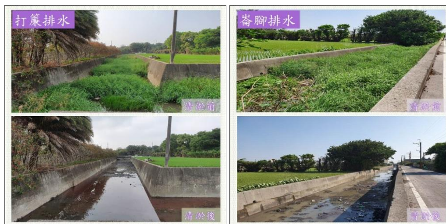
圖 21：打簾排水及崙腳排水施工（前）（後）
