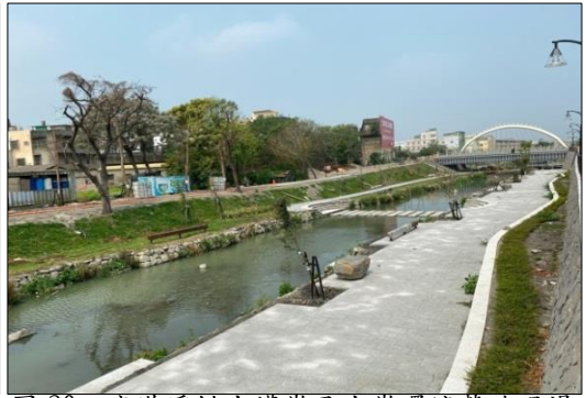
圖 20：鹿港溪排水護岸及水岸環境營造現場
